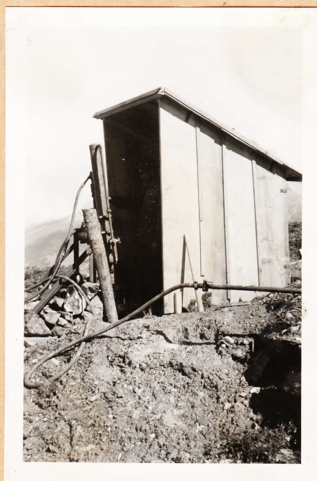
Bohrung Nr. 1 mit Craelius-Apparat
